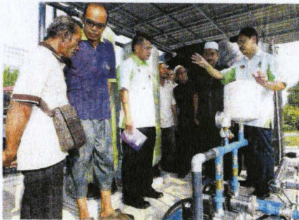
PENDUDUK diberi penerangan mengenai sistem telaga tiub yang berjaya dibangunkan di Kampung Kuala Pai Padang Terap Kedah baru-baru ini.
